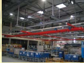
Suwnica dwudźwigarowa w fabryce MAN – Niepołomice (2007)
